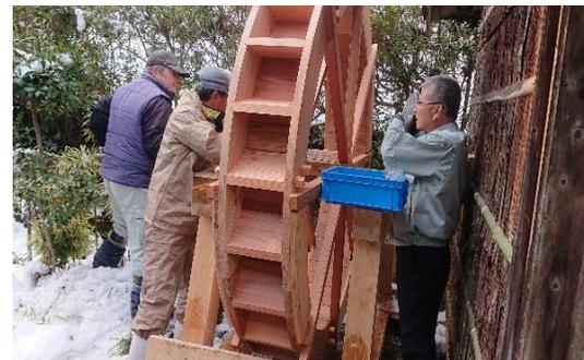
令和3年7月の豪雨により被害を受けた深谷温泉の水車施設（水車本体。米つきおよび粉ひき）の修繕、また新たな水利の確保や電源工事などにより、水車施設を復元しました。
